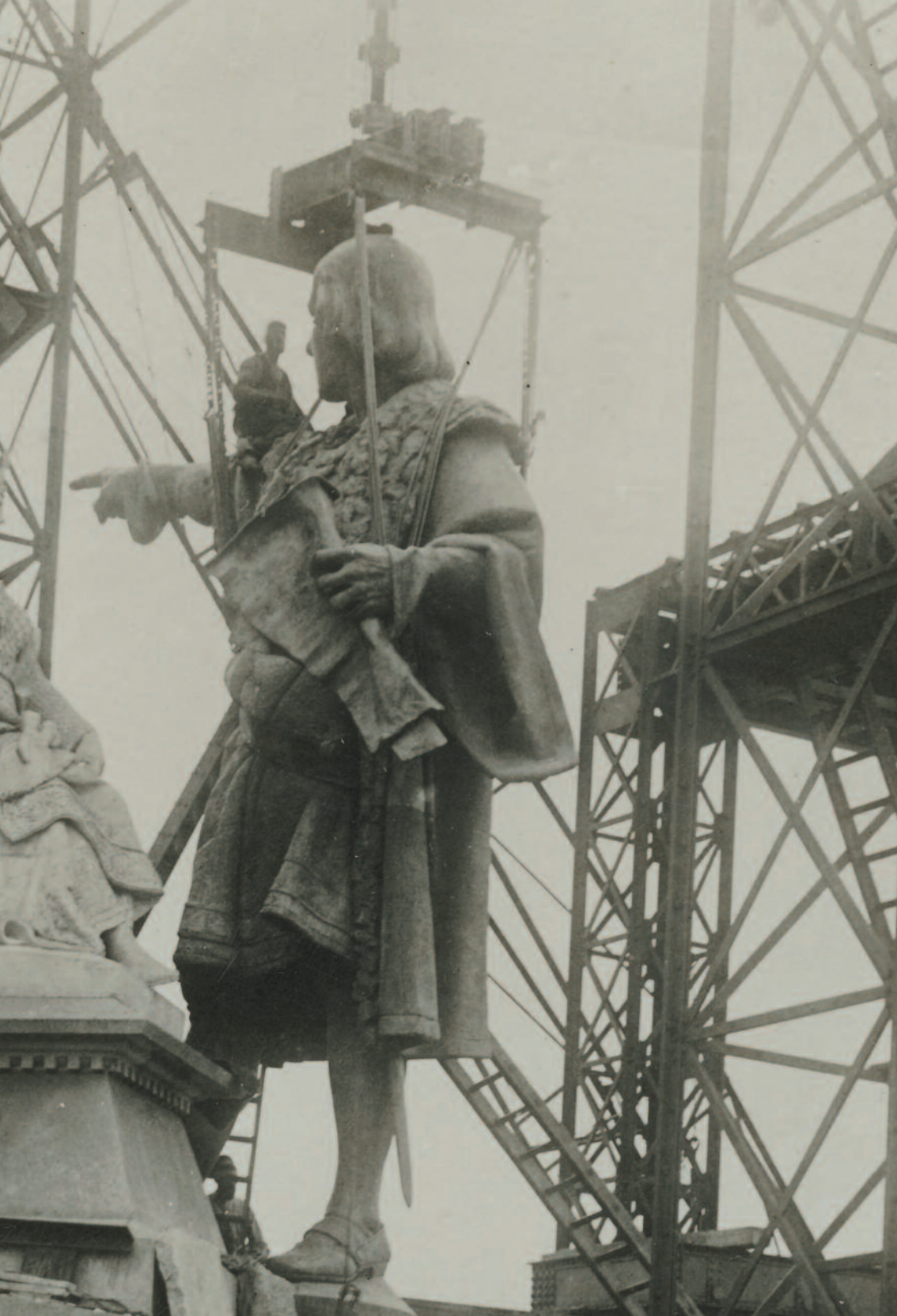
Muntatge del monument a Colom. © Arxiu Fotogràfic de Barcelona (AFB). Autor desconegut
